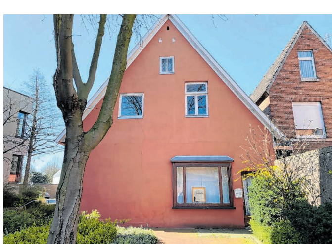
So sah die Rückseite des historischen Gebäudes vor der Sanierung aus.
