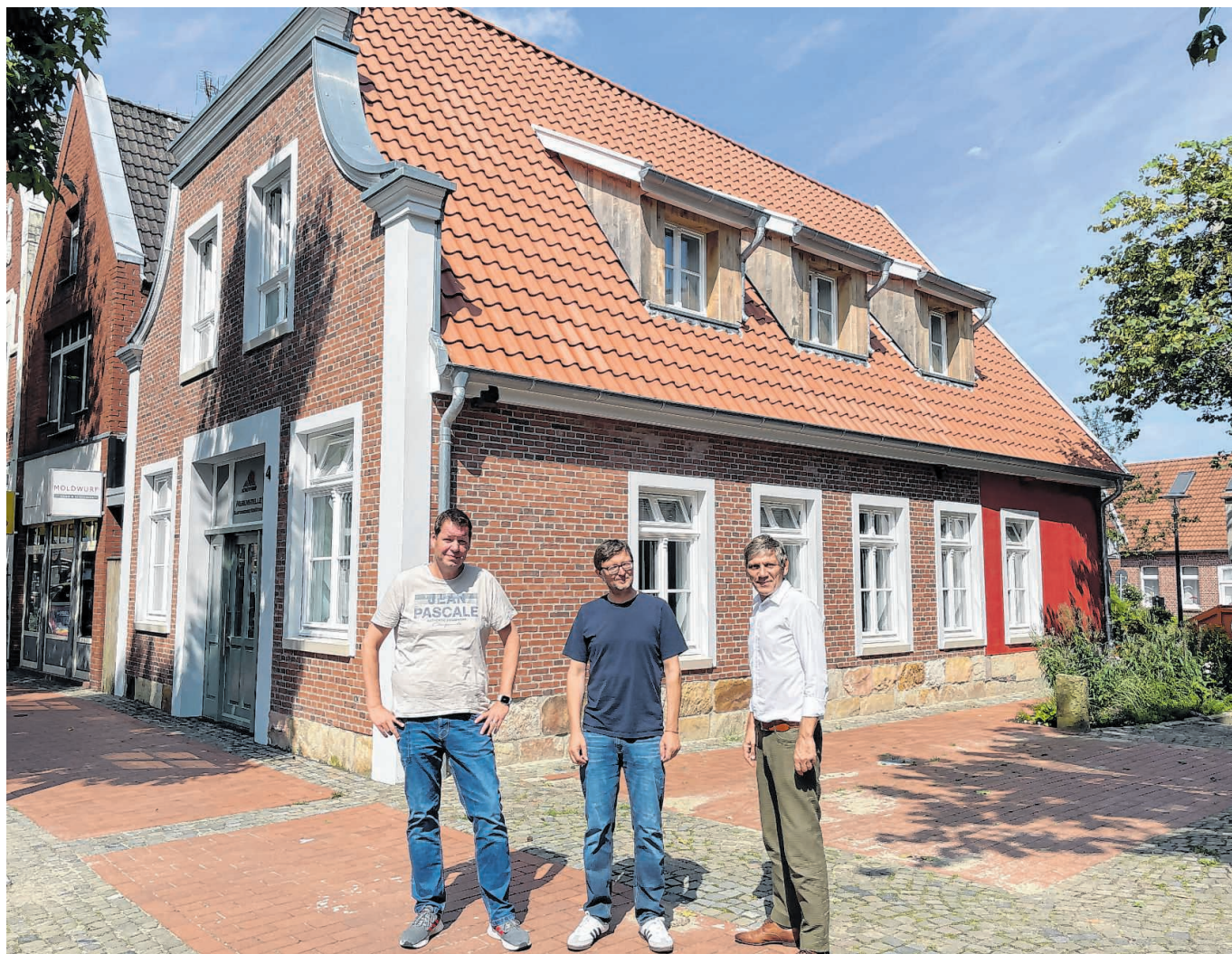
Freuen sich über die Sanierung (von links): Michael Heßling vom Bauamt, Architekt Jens Mülder und Bürgermeister Manfred Windhaus.
